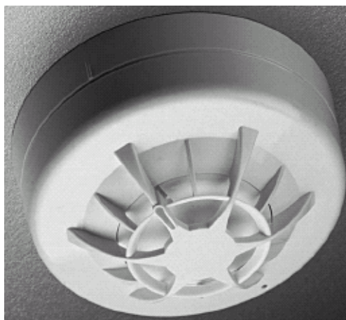
Рисунок 5-59: Датчик пожара с цоколем
