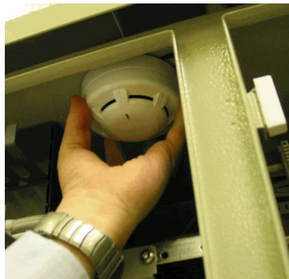
Рисунок 5-80: Демонтаж датчика пожара
